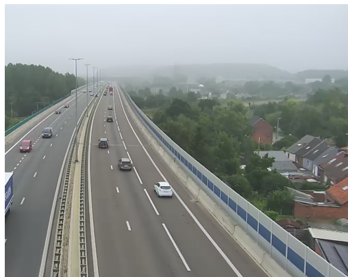
Figuur 3: E314 richting Heerlen ter hoogte van viaduct Willese met weefstrook
