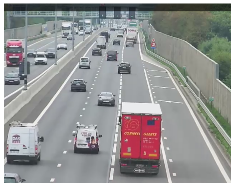
Figuur 5: E314 richting Heerlen ter hoogte van viaduct Willese met geopende spitsstrook (groene pijl)
