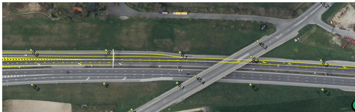
Uitvoegzone knooppunt Aalbeke (afrit van E17 komende van Antwerpen naar E403) Witte markering = oude situatie, gele markering = nieuwe situatie (Bron: Agentschap Wegen en Verkeer)
