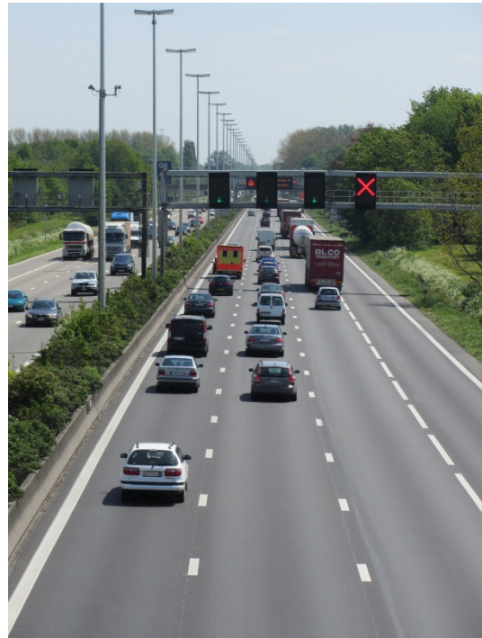
E34-E313 tussen afrit en oprit parking Ranst (spitsstrook + 3 rijstroken)
